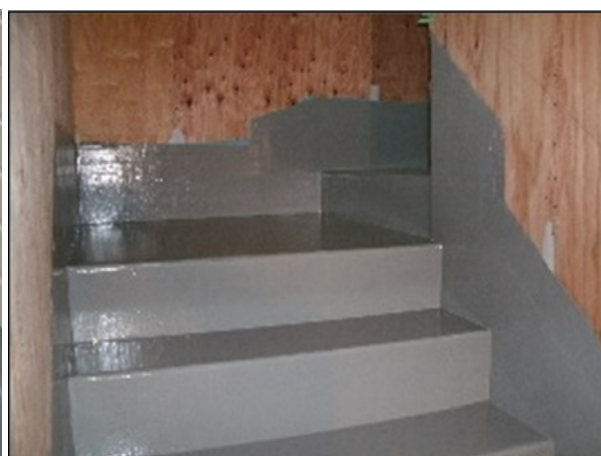
写真 1.2.2 屋外階段の 塗膜防水施工の事例
