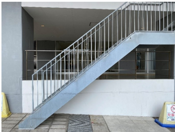
写真 1.3.4 塗料による防錆措置の事例
